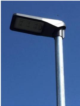
Die Beleuchtung in den Ortsteilen der Gemeinde Tülauteil beruht noch in weiten Bereichen auf der Technik mit Quecksilberlampen. Um einen Beitrag zur CO<sub>2</sub> Reduzierung und damit zum Klimaschutz zu leisten, werden in einem ersten Schritt die gesamte „Salzwedeler Straße“ mit der Ortsdurchfahrt B248 sowie die Straße „Im Hög“ auf die Energiesparende LED-Technik umgestellt.
